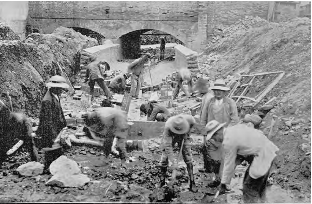
Alcantarillado—Colector del río San Francisco entre calles 7a. y 8a.
