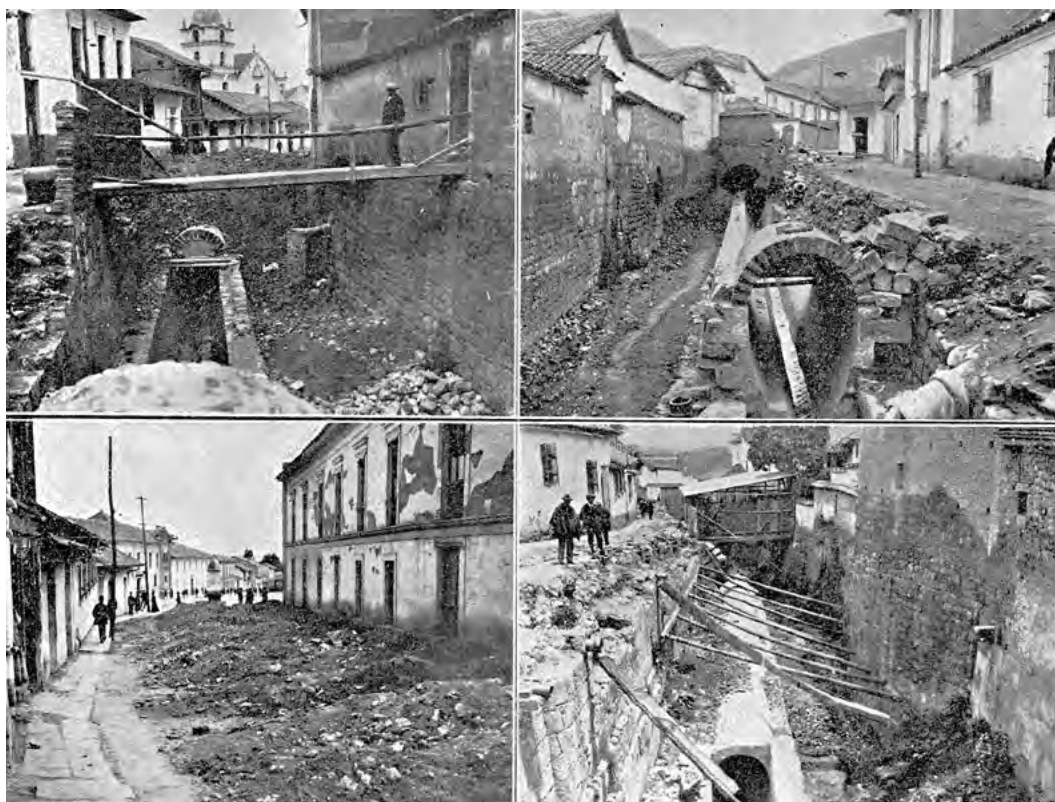
Canalización del Río San Agustín
